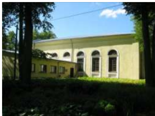
28.attēls. Novada nozīmes kultūrvēsturiskais objekts – Nīcas luterāņu baznīca. Foto: SIA „Metrum”, 2012..
